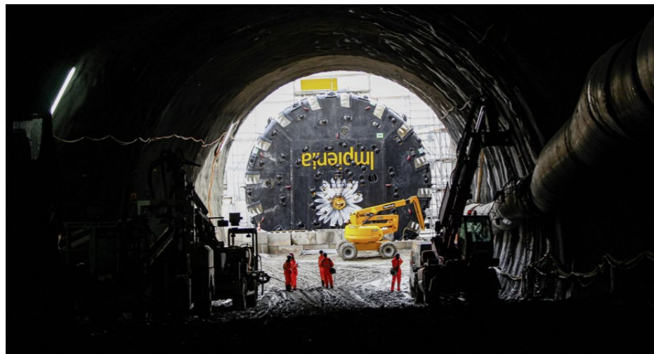
Tunnelbohrmaschine von Implenia im Bözbergtunnel.
